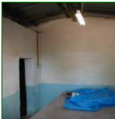
Salle d'accouchement de la centre de santé de Zambala, avec éclairage solaire.
