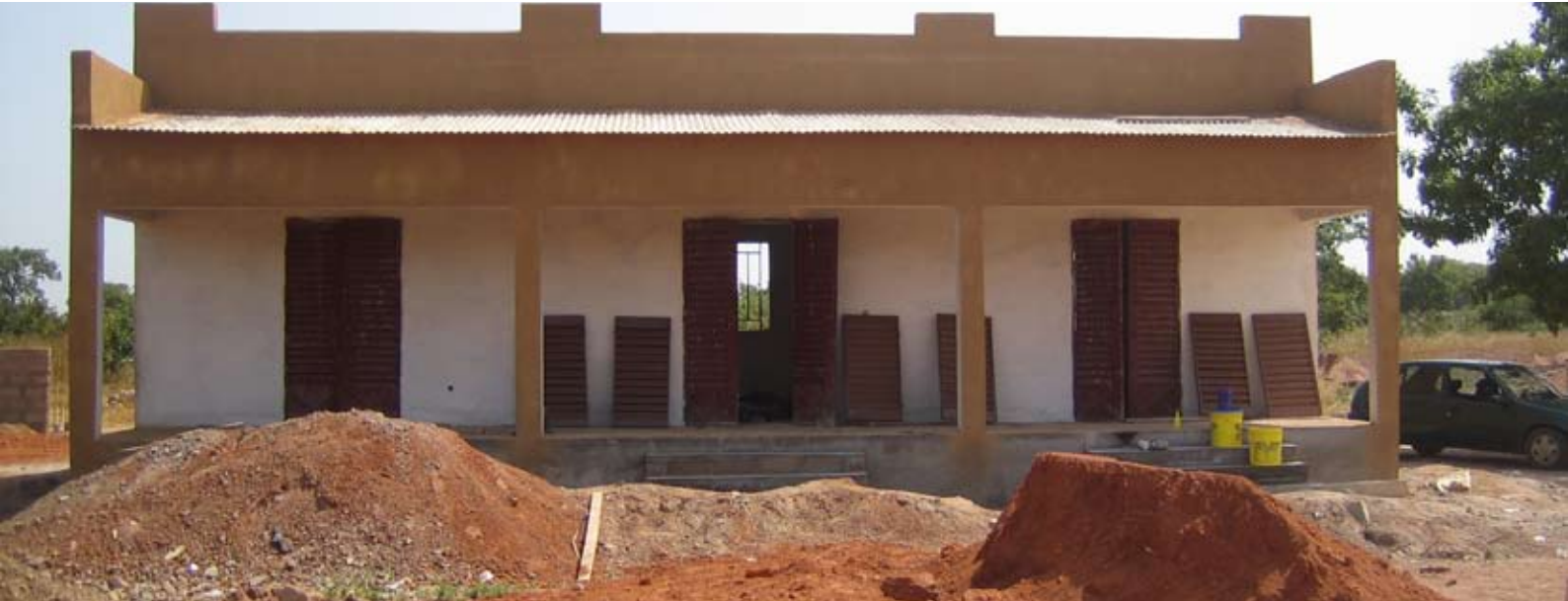
Finition des travaux de construction du Centre Yiriwa So des femmes à Koumantou, Mali
